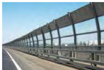
Rys. 6. Dźwiękochłonne ekraany, ustawiane obok autostrad, kilkukrotnie zmniejszają poziom hałasu
