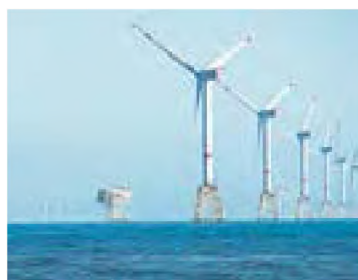
Rys. 11. Generatory wiatrowe ustawione wzdłuż wybrzeża Danii, całkowicie zabezpieczają północ państwa w energię i umożliwiają sprzedaż energii innym państwom
