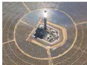
Rys. 10. Jedna z największych na świecie elektrowni słonecznych – „Ivanpah” (czyt. Ajwanpa) (USA, Kalifornia). 173 tys. zwierciadeł odbija światło słoneczne i skierowuje je na wierzchołki trzech wież, na których znajdują się kotły z wodą. Gorąca para trafia na tarcze turbin, znajdujących się wewnątrz wież
