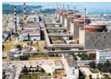
Rys. 27.3. Zaporoska elektrownia atomowa – największa elektrownia atomowa w Europie, w której pracuje 6 atomowych bloków energetycznych
