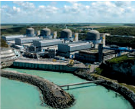
Fig. 8. CAE «Paluel» - cea mai mare centrală atomoelectrică din Franța
