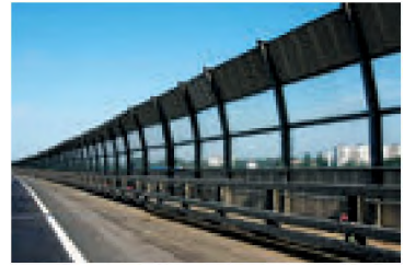
Fig. 6. Ecranele pentru zgomot, instalate lângă autostrăzi, micșorează nivelul zgomotului de câteva ori
