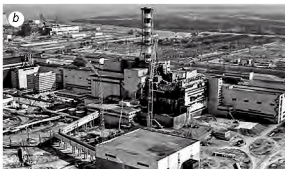
27.7. ábra. A Csernobili Atomerőmű négyes energiablokkja a robbanás előtt (a) és után (b)
