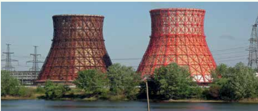
Рис. 67. Градирні на харківській теплоелектроцентралі (ТЕЦ), яка забезпечує гаряче водопостачання і опалення житлових та промислових об'єктів
