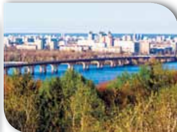
Мал. 119. Використання теплової дії струму під час контактного зварювання металів. Міст імені Є. О. Патона в Києві — перший у світі суцільнозварний міст завдовжки 1543 м
