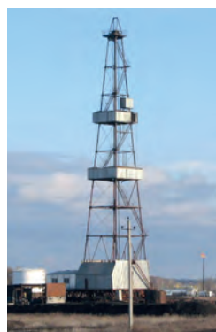
Instalație petrolieră de foraj în regiunea petroliferă și gaziferă Estică
