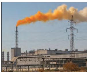
Rys. 76. Emisja gazów zawierających tlenek azotu \text{NO}_2 (tzw. „lisi ogon”)
