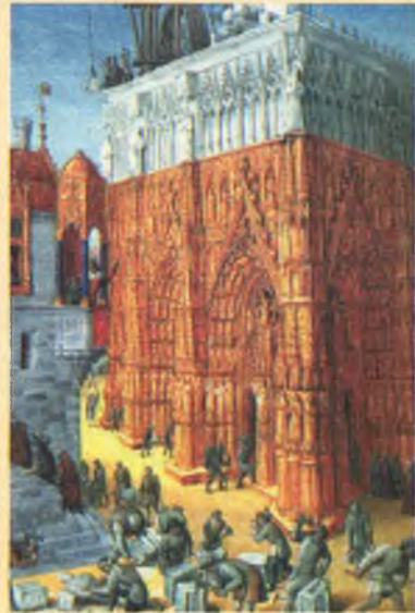
Жан Фуке. Будівництво храму (XV ст.)
