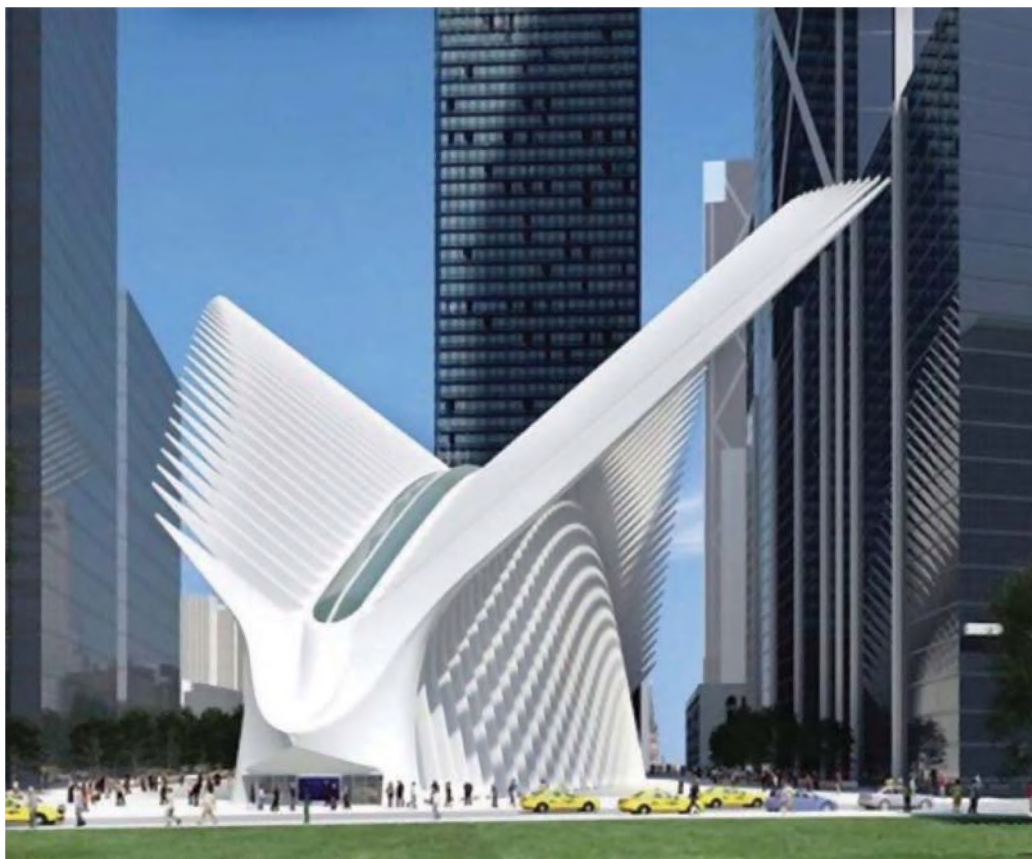
С. Калатрава. Станція Нью-Йоркського метрополітену
