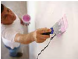
Мал. 146. Перед початком фарбування тріщини слід прошпаклювати
