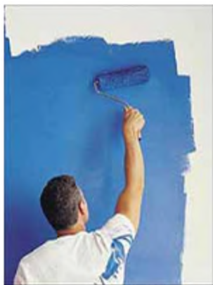
Мал. 148. Валик використовують для фарбування великих площ
