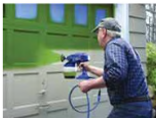
Мал. 142. Фарборозпилювач значно прискорює процес роботи
