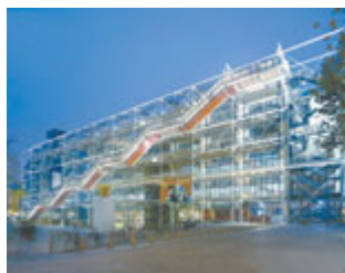
Le centre Pompidou
