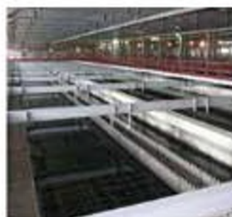
Мал. 42. Використання фільтрів на водоочисних станціях
