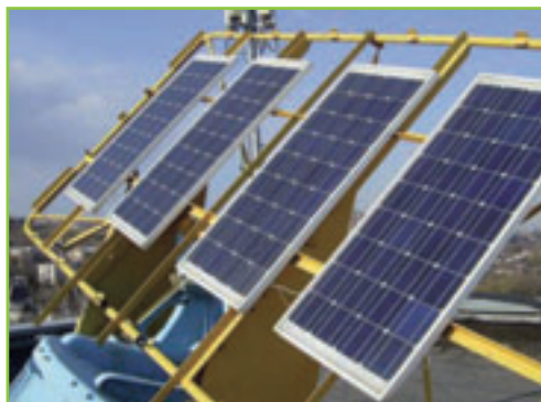
Рис. 13. Угол наклона солнечных коллекторов на гелиотермальной электростанции
