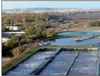
Рис. 91. Сооружение для очистки промышленных стоков
