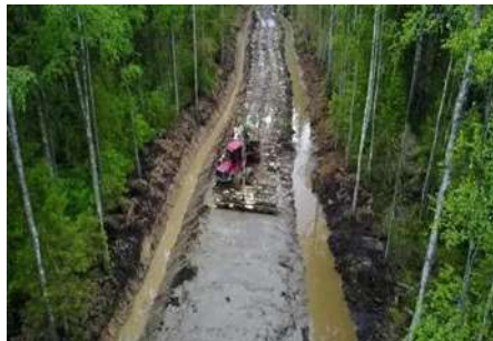
Мал. 57.2. Будівництво дороги в лісі
