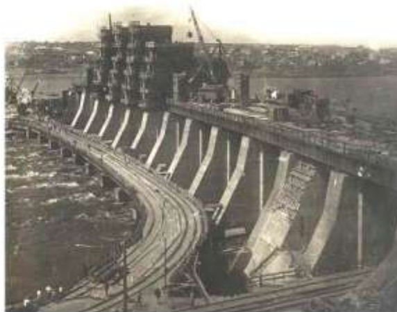
Будівництво Дніпрогесу. 1930 рік
