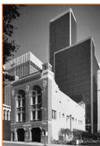
Архітектурне фото. Лос-Анджелес. Каліфорнійська пожежна станція № 28
