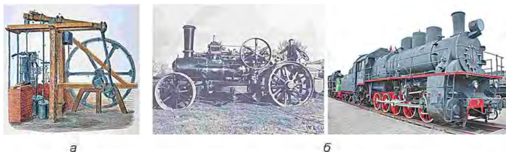
Мал. 177. Парові машини: а – для перекачування води; б – для приведення в рух різних механізмів
