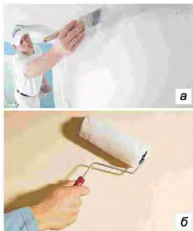
Мал. 168. Прийоми нанесення фарбувальних сумішей: а – флейцем; б – валиком
