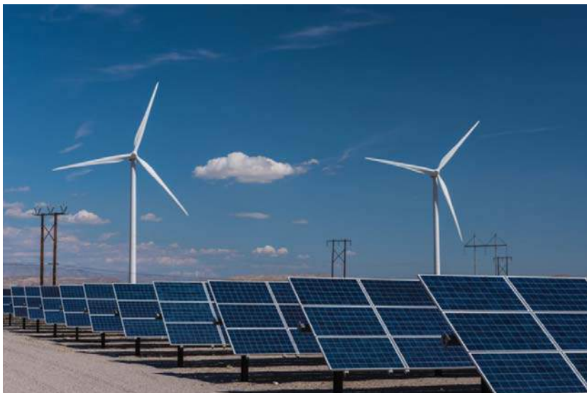
Рис. 200. Будівництво вітряних і сонячних електростанцій
