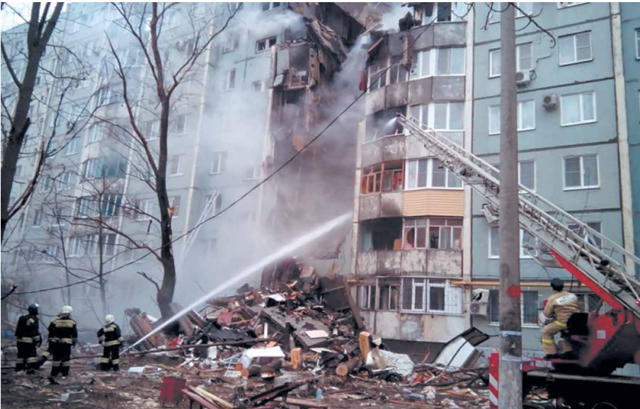
Мал. 69. Порятунок постраждалих з верхнього поверху зруйнованої будівлі з використанням пожежної автодрабини
