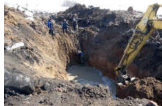
Іл. 33.11. Викопування водовідвідної канави
