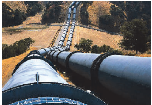
Одна з ділянок газопроводу Дашава – Київ
