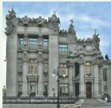
Будинок з химерами. м. Київ. Сучасне фото
