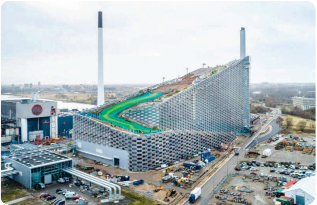
Електростанція з переробки відходів у Копенгагені (Данія)
