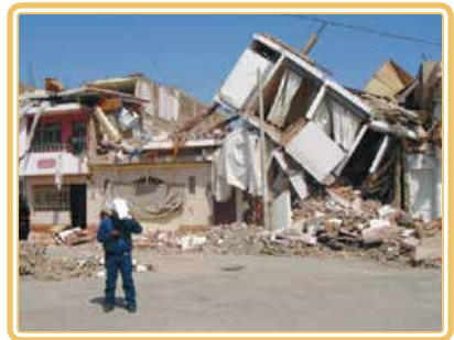
La casa caída a causa del terremoto.
