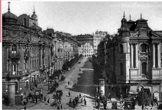
Київ, вул. В. Городецького (за більшовиків вул. К. Маркса)
