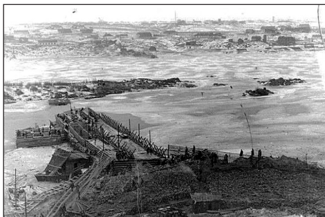
Începutul construcției Dniiprogos
