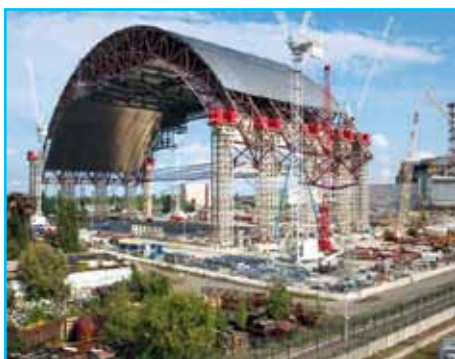
Мал. 3. Будівництво нового саркофага для 4-го енергоблоку Чорнобильської АЕС
