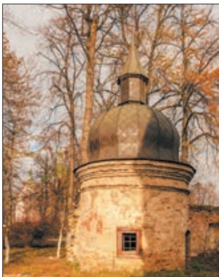
Turnul de colț al pereților Mănăstirii Kyrylivska. Arhitect I. Grigorovici-Barski. Anul 1748—1760. Aspect modern.
