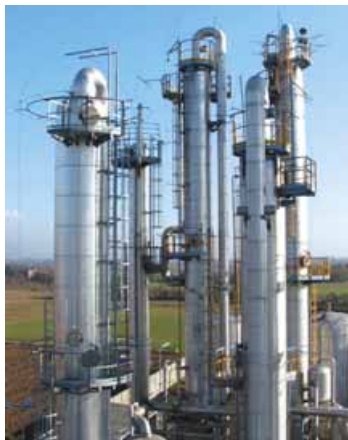
Рис. 31.4. Промислові ректифікаційні колони великої потужності – споруди 40–60 м заввишки й діаметром 3–6 м
